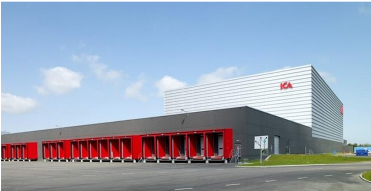
Figur 7.7: Nästan alla nya lager byggs med ändlastning som förutsätter att lasten kommer på trailer eller i container och inte i en konventionell järnvägsvagn. Bilden visar ICAs nya lager i Västerås.
